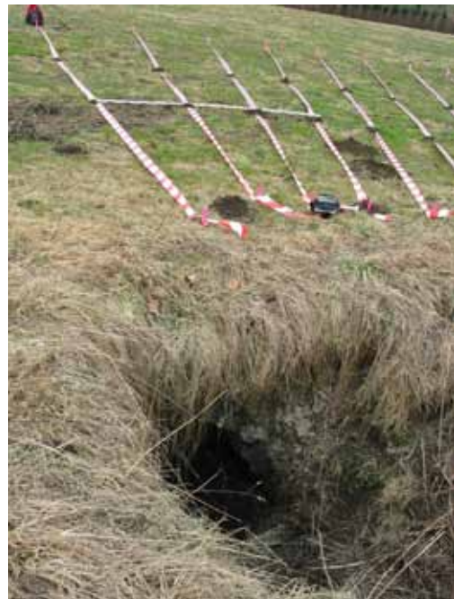
Abb. 61: Der Stollen erreicht an dem Hang die Tagesoberfläche. Das Gelände über diesem Hohlraum steigt leicht an.
