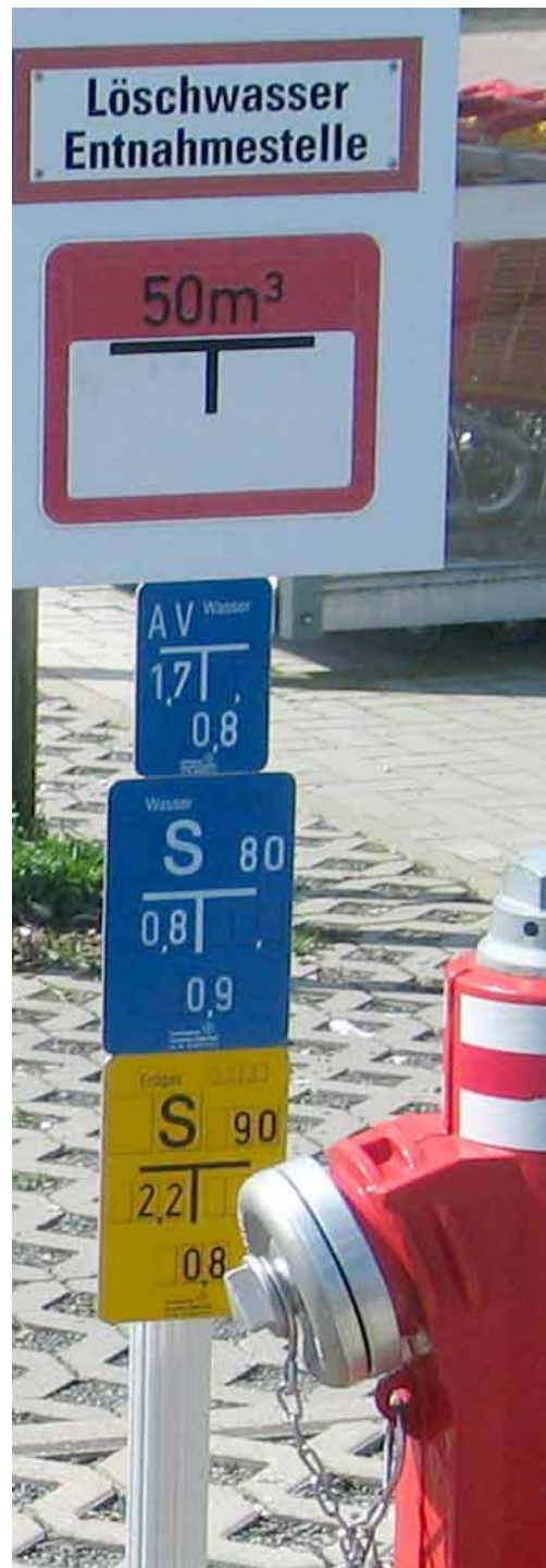
Abb. 13: Hinweise für Löschwasserzisterne, Absperrschieber (S) für Wasserleitung 80 mm (blau) und Gasleitung 90 mm (gelb). Die Zahlen geben die Entfernung in Metern in zwei Richtungen an. kanaldeckel.htm
