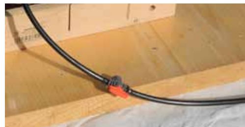
Abb. 01: Dünner Wasserschlauch (6 mm) mit Abstell- oder Drossel-Ventil (Gartenabteilung Baumarkt)
