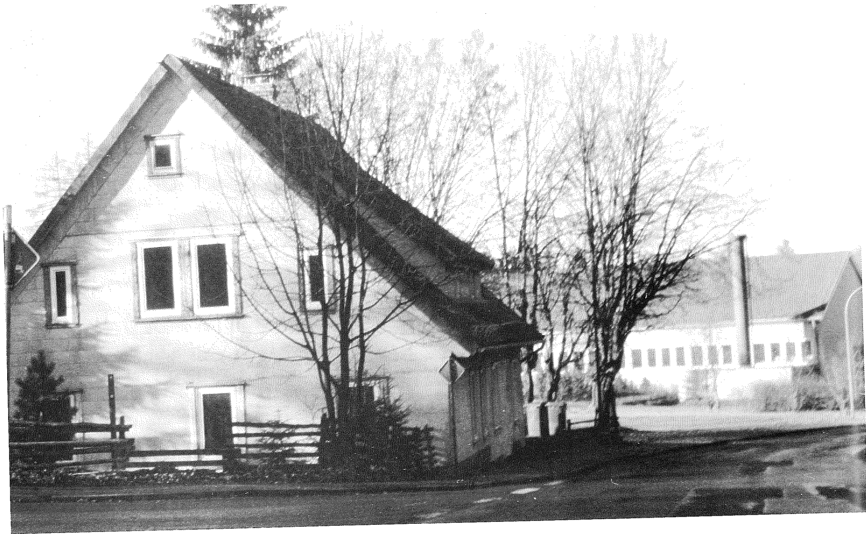
Zechenhaus der Grube Englische Treue an der Altenauer Straße um 1997. Im Hintergrund die Werkhalle des Metallurgischen Zentrums.
