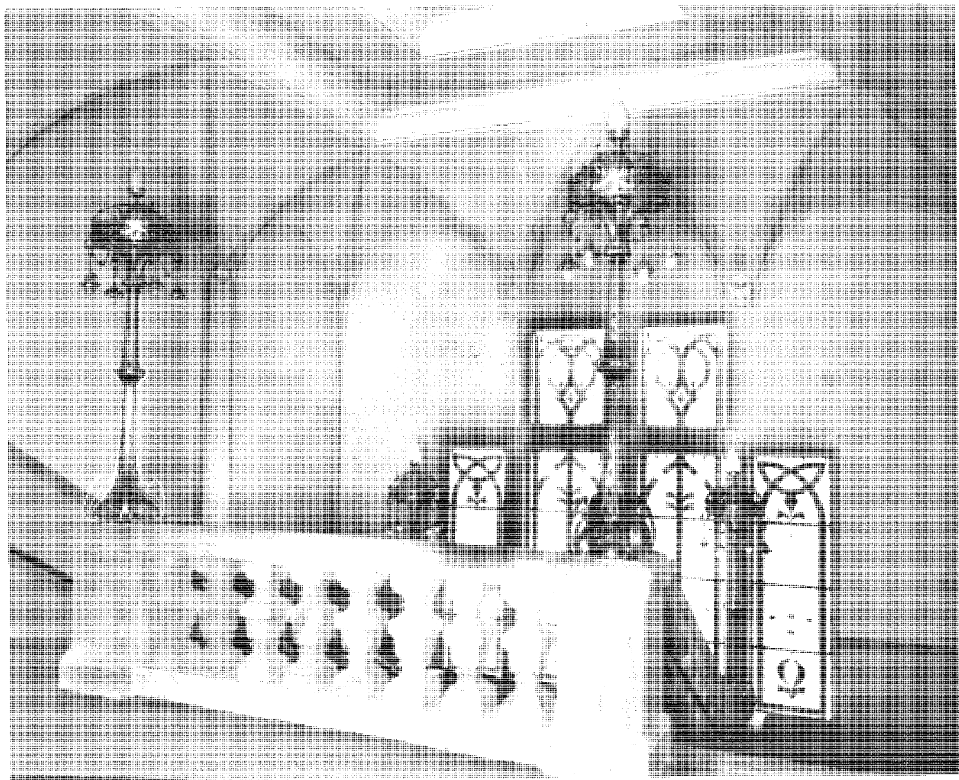
Blick vom zweiten Ober- geschoss ins Treppenhaus, Hofseite (1907).
