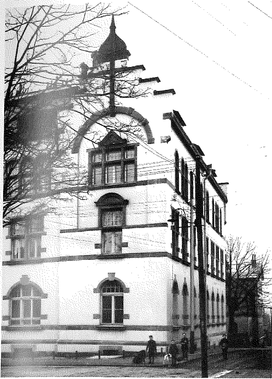
Das 1902–04 gebaute Hüttenmännische Gebäude an der Ecke Graupenstraße–Pastorenbrink. Links: Kurz nach der Fertigstellung um 1910. Schon wenige Jahre danach traten Schäden im Verputz auf (Mitte, um 1920), so dass 1926 eine schlichte Oberharzer Verbretterung aufgebracht wurde (rechts, um 1930).
