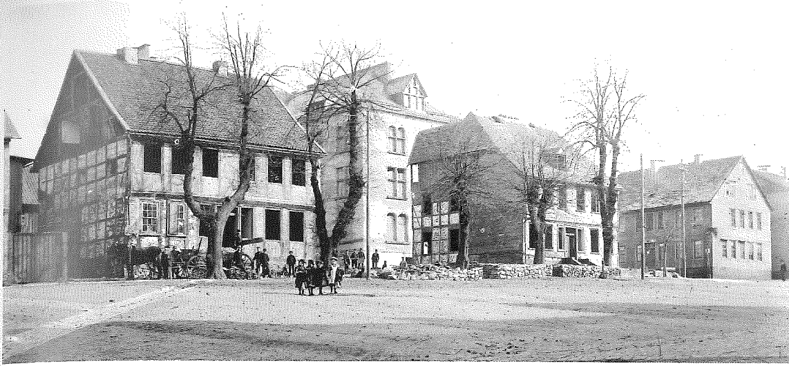
Dem Neubau mussten die Predigerhäuser am Markt weichen. Durch die Abrisslücke war das schon fertige Hüttenmännische Gebäude zu sehen. (Foto März 1903)
