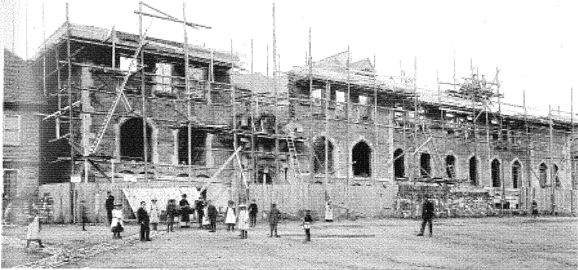
Der erste Bauabschnitt des Hauptgebäudes erstreckte sich bis an das alte Bergschulhaus. (Foto September 1903)
