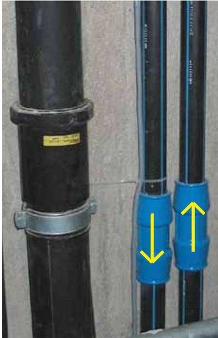
Abb. 24: Hin- und Rückleitung mit Kühlwasser. Der Verbraucher steht in der Etage darüber, die Kühlanlage im Keller.
