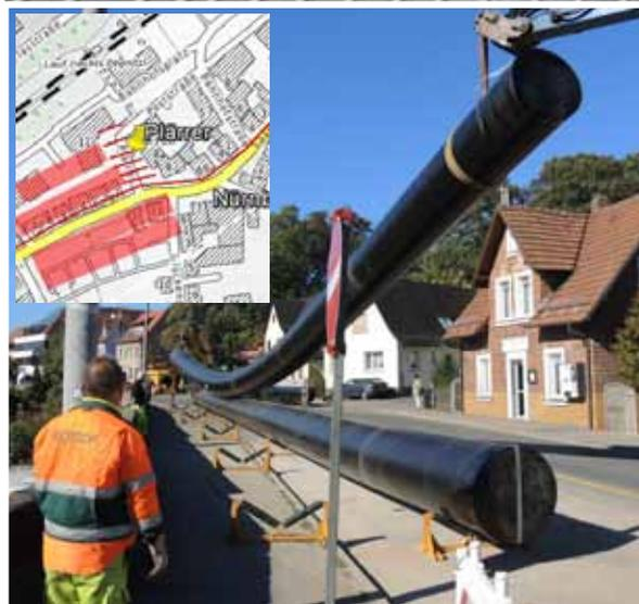
Abb. 26: Sanierung einer etwa 100 Jahre alten Wasserleitung (Durchmesser etwa 1m) aus Gußrohren. Die Leitung verläuft unter der Straße mitten durch den Ort,
